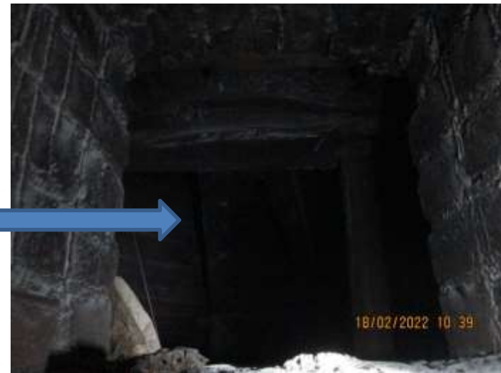
Выход вен. канал из галереи барабана
