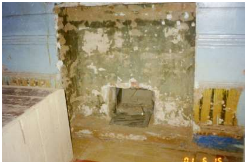
Вентиляционная галерея барабана купола
