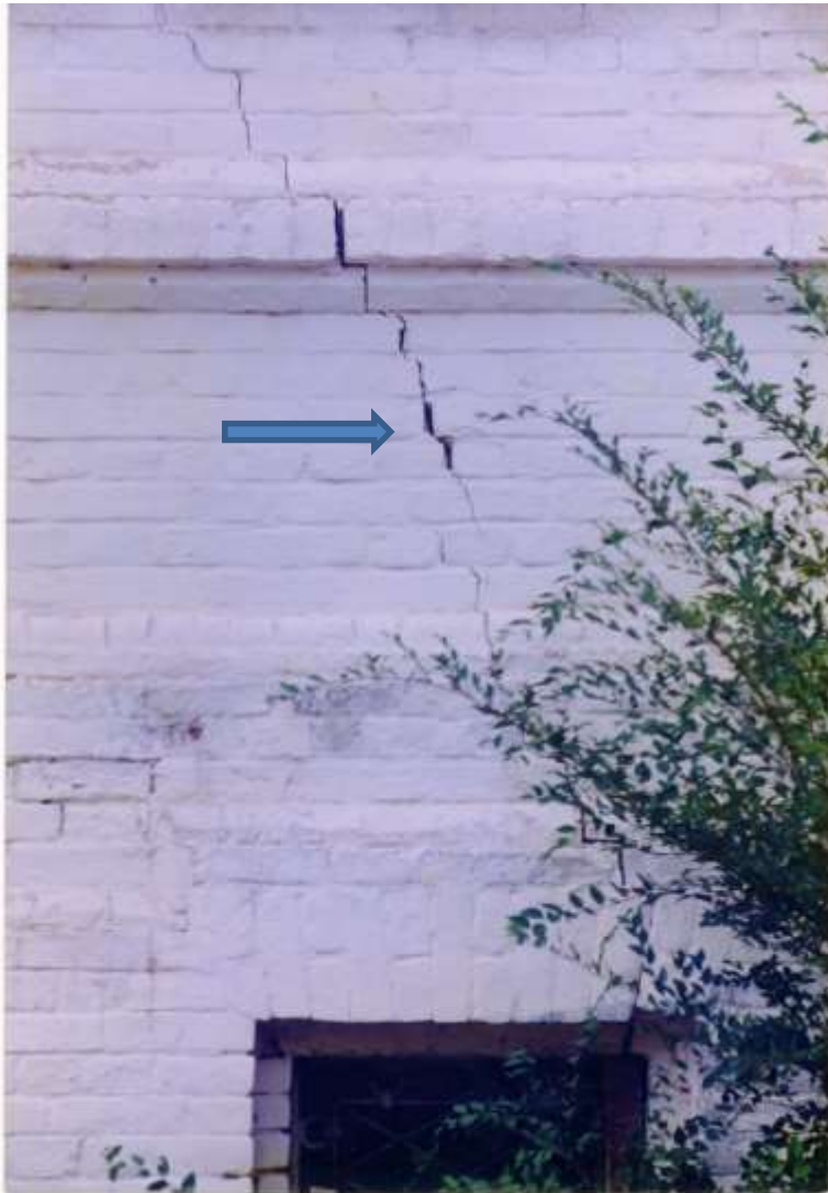
Трещины, идущие от оконного проема 1-го яруса до оконных проемов подклета
