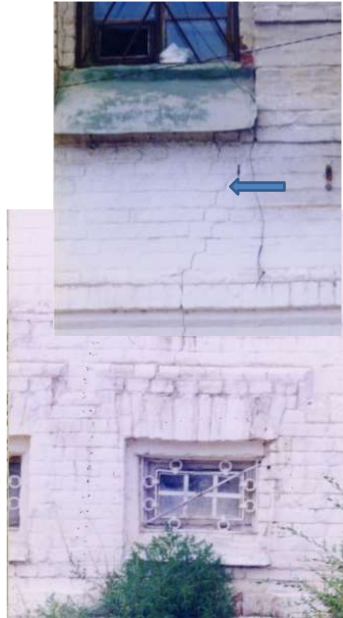
Трещины, идущие от оконного проема 1-го яруса до оконных проемов подклета
