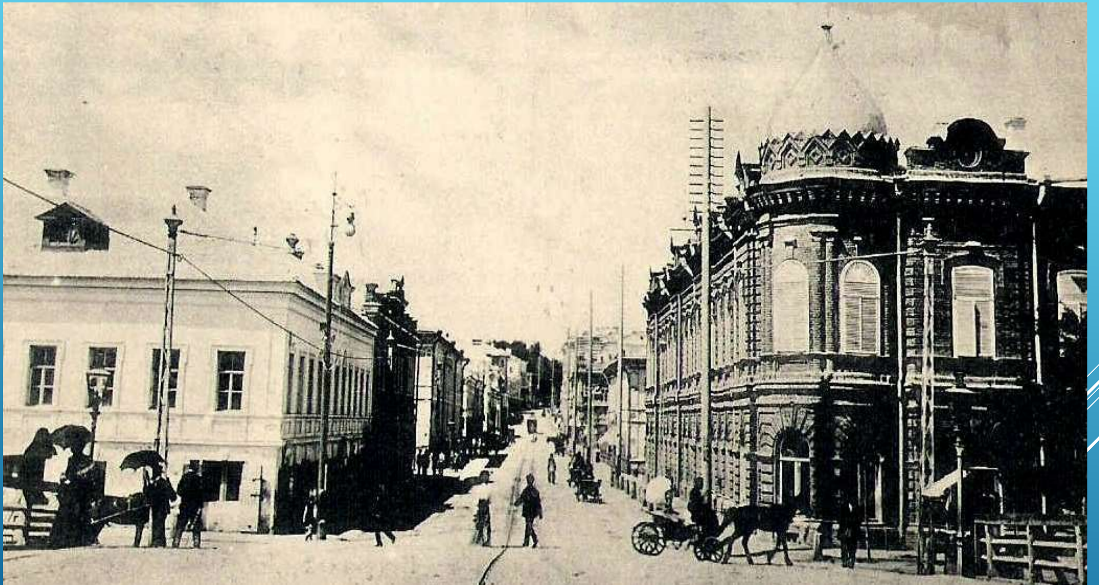
ПЕРСПЕКТИВА УЛ. ПАРОБИЧЕБУГОРНОЙ. ДОМ БРАТЬЕВ ЗАХАРОВЫХ НА НАБЕРЕЖНОЙ ВАРВАЦИЕВСКОГО КАНАЛА. ФОТО НАЧ. 20В.
